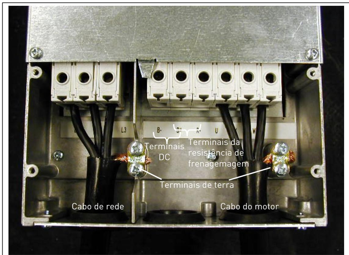
Figura 6-20. Instalação dos cabos no Vacon NXL, MF6
